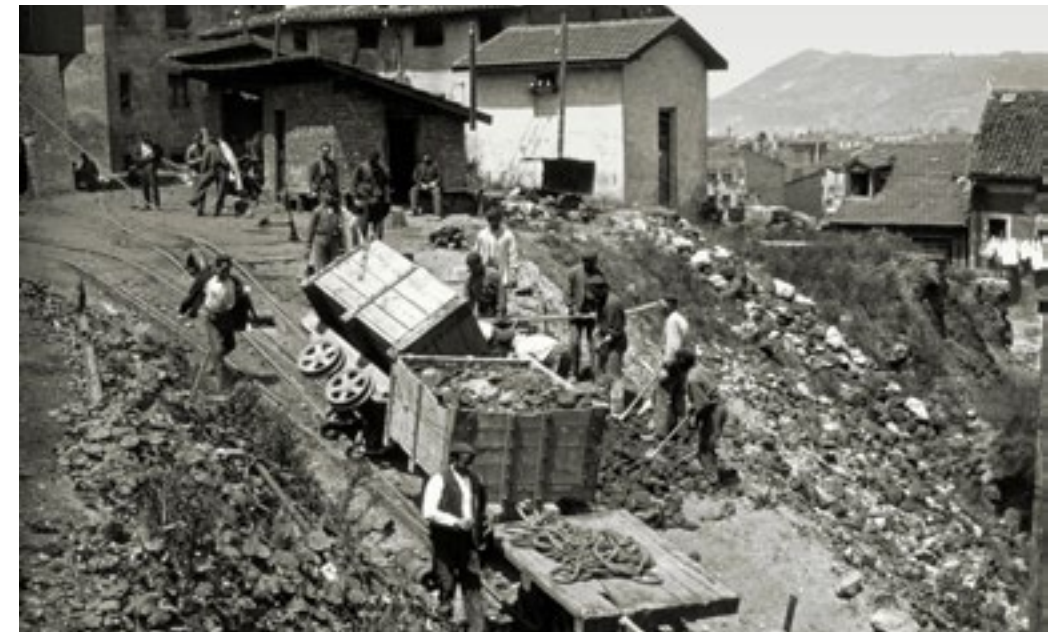
Accidente en la mina San Luis, en el barrio bilbaíno de Miribilla, en 1916.
